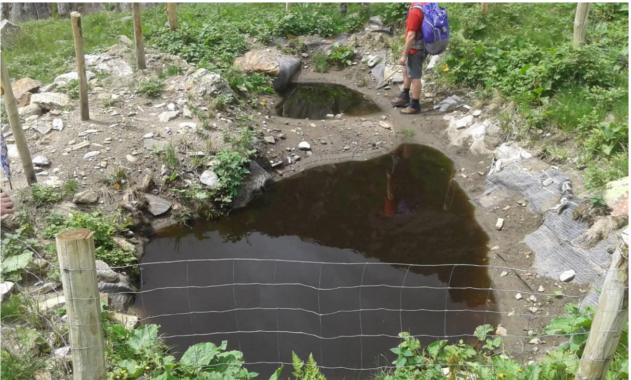
Alpe Predone. Data la conformazione del substrato e la presenza di rocce difficilmente rimovibili, è stato deciso di diversificare il fondo in modo da ottenere due piccole zone umide.
