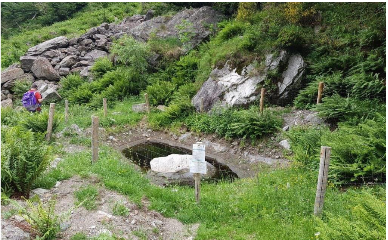
Alpe Curvegio. Anche in questo caso si osservi che l'acqua è presente, ma più bassa rispetto alla fascia di oscillazione. Nonostante ciò, le piante hanno mostrato un buon attecchimento.
