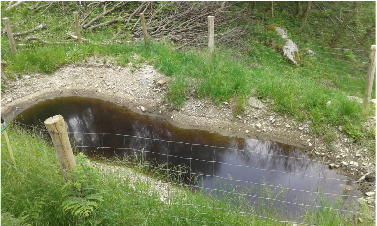
Caserma La Foppa. Si osservi la fascia di oscillazione più bassa rispetto al limite tra il telo in bentonite e il terreno.
