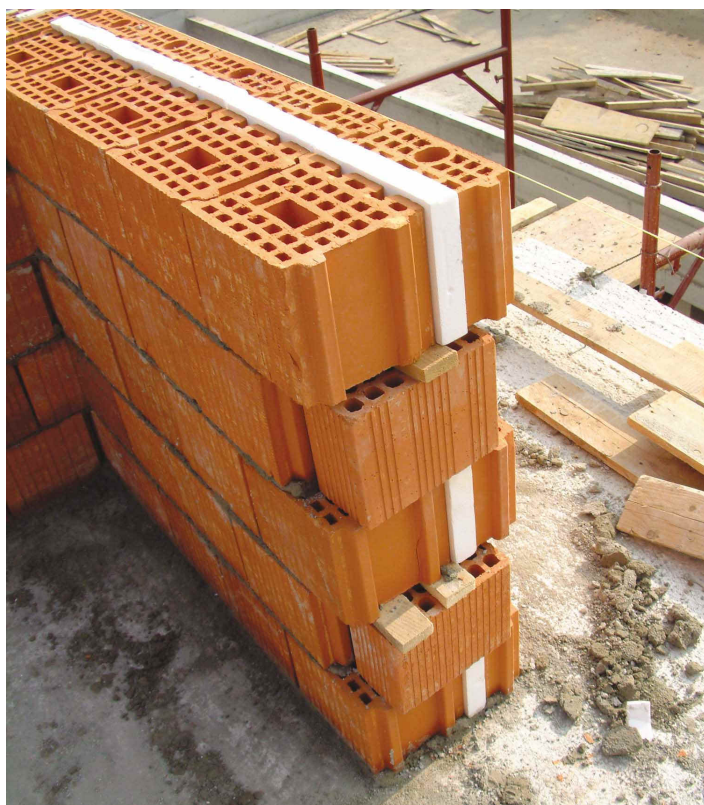
Isolamento termico delle pareti
