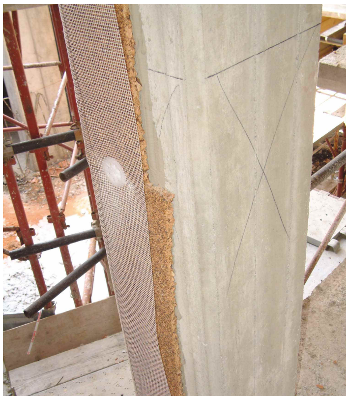
Isolamento termico delle pareti
