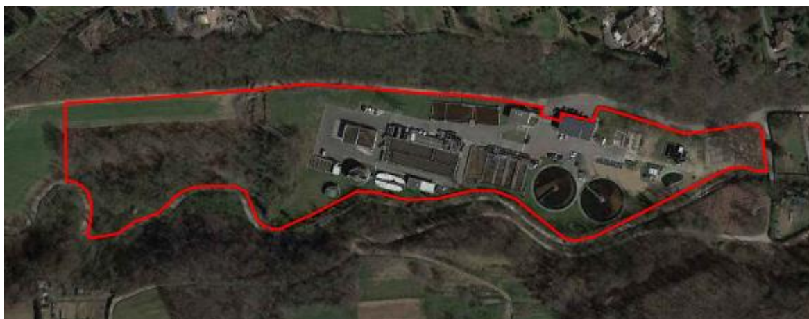
Figura A1. Ortofoto dell'intero impianto.
