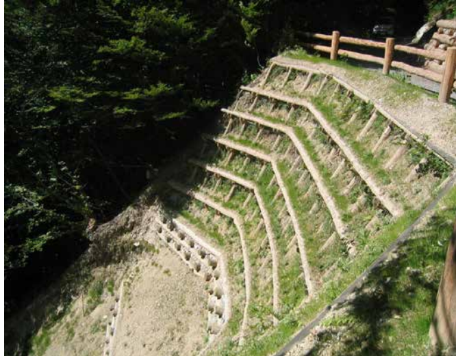
Sistemazione di una frana in comune di Pello Intelvi
